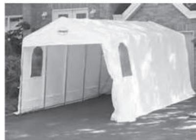
L'abri doit être fabriqué en toile de fibre synthétique translucide montée sur une ossature métallique tubulaire préfabriquée, de fabrication reconnue et avoir une capacité portante suffisante permettant de résister aux accumulations de neige.
