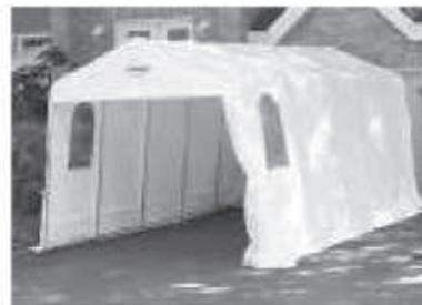
Les abris d'hiver doivent être de marque reconnue, être construits d'une structure métallique et être revêtus de façon uniforme de toile ou de polyéthylène tissé et laminé.
